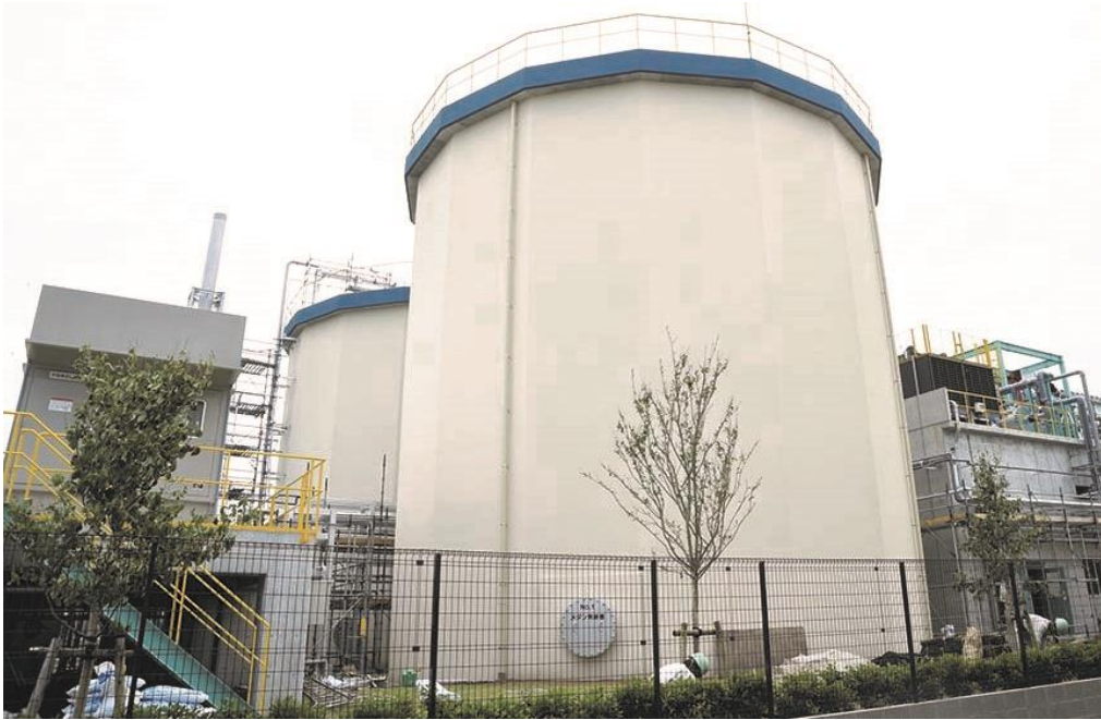
バイオガス発電施設 発酵槽
