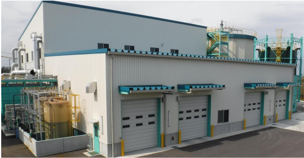
バイオガス発電施設全景
